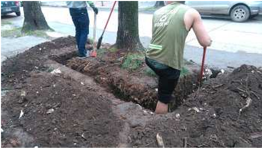
Figura 11: Trabajos actuales de tratamiento en raíces y aperturas de cazuelas. Fuente: Verónica Gallegos
